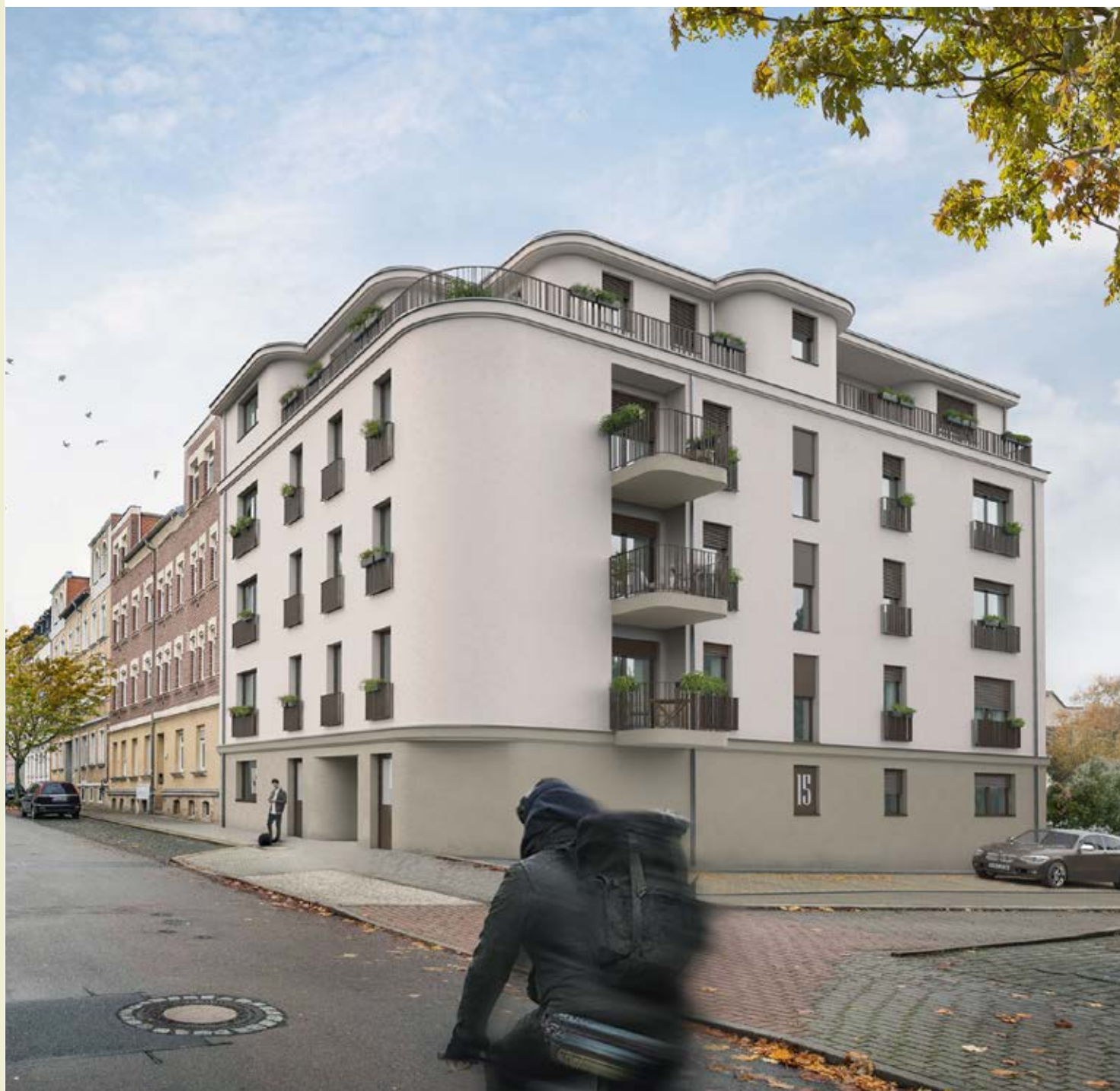
Ein neuer Blickfang in der Schkeuditzer Innenstadt
